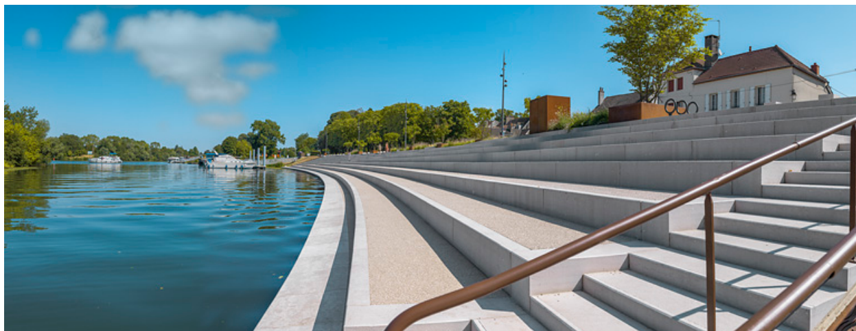
Vue d'ensemble des quais après leur réaménagement.
