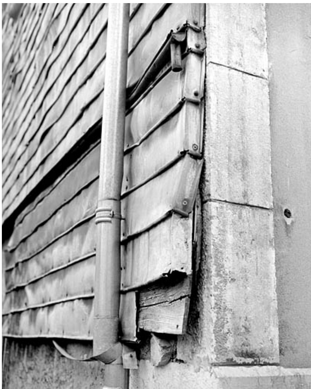
Essentage de tôle sur le mur sud.
