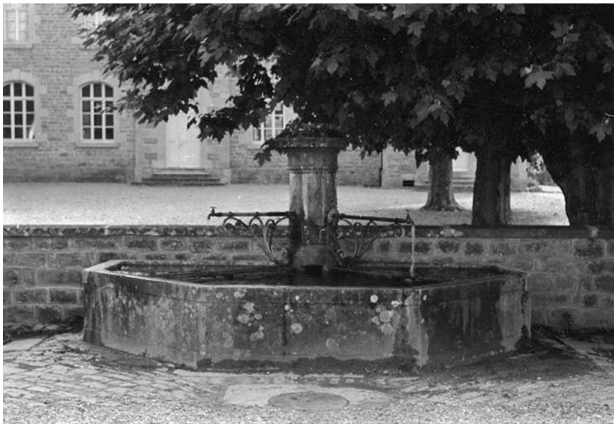
Fontaine en pierre, 19e siècle : vue d'ensemble
