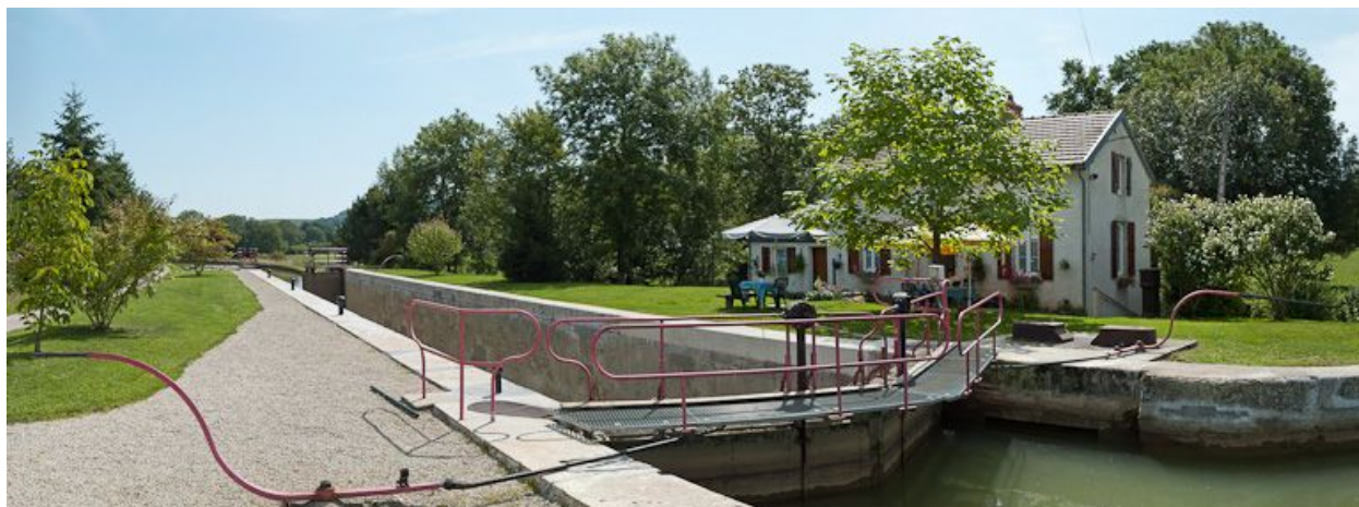
Vue d'ensemble du site d'écluse.
