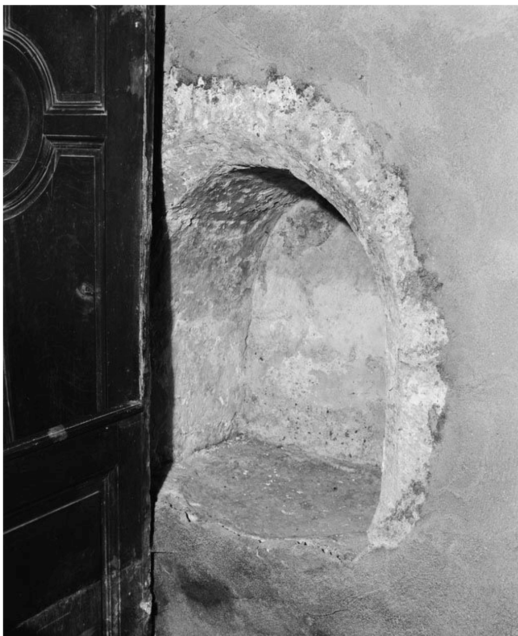
Lavabo du mur droit du chœur.
