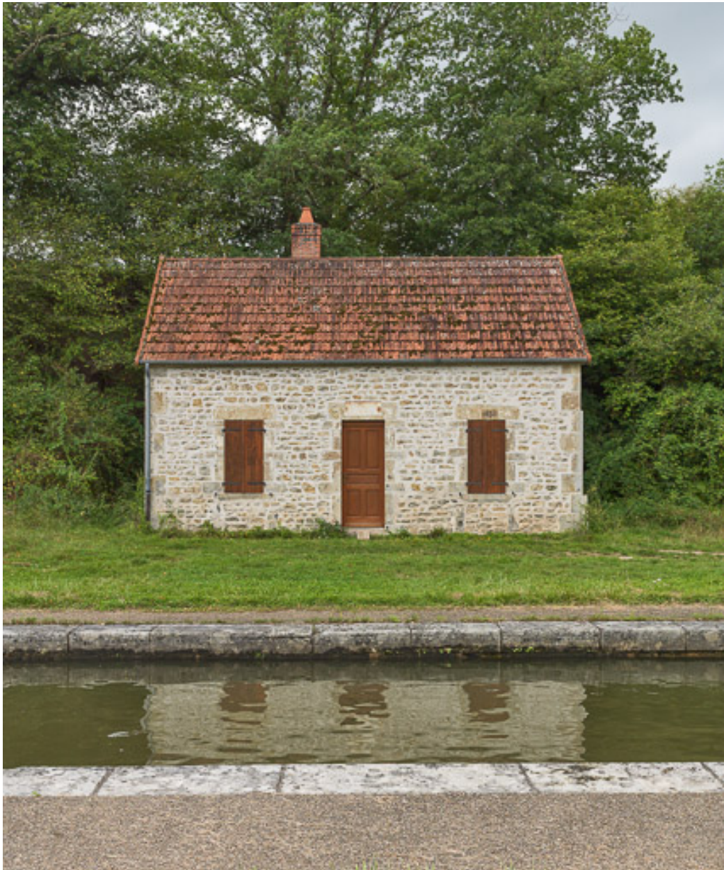
Vue de la maison éclusière.
