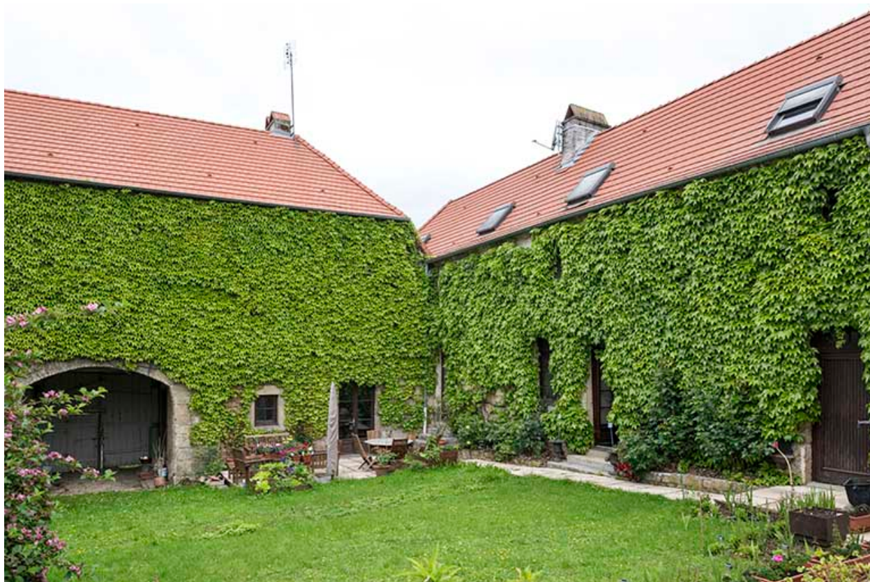
Les façades postérieures.
