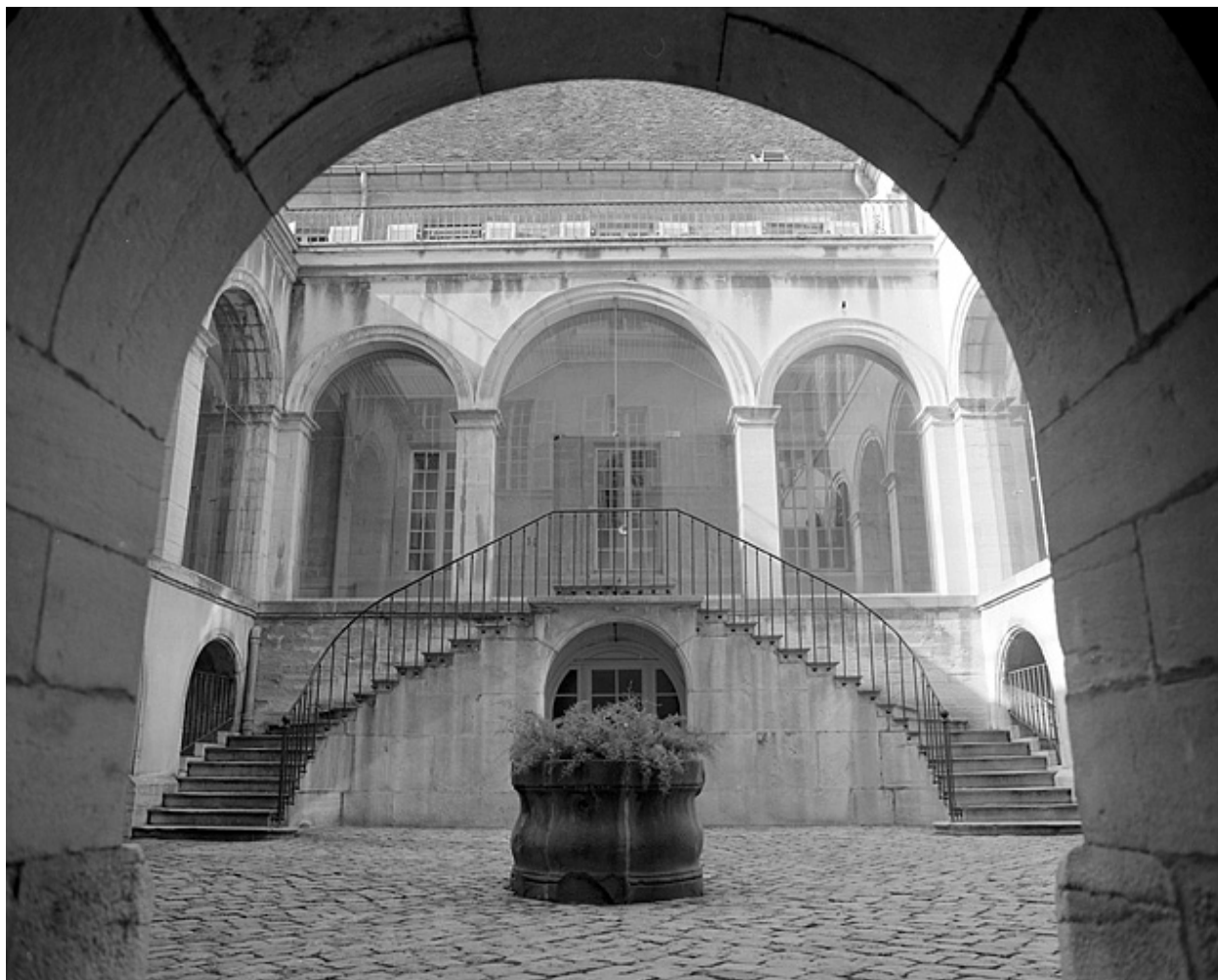
Cour intérieure, escalier : côté ouest.
