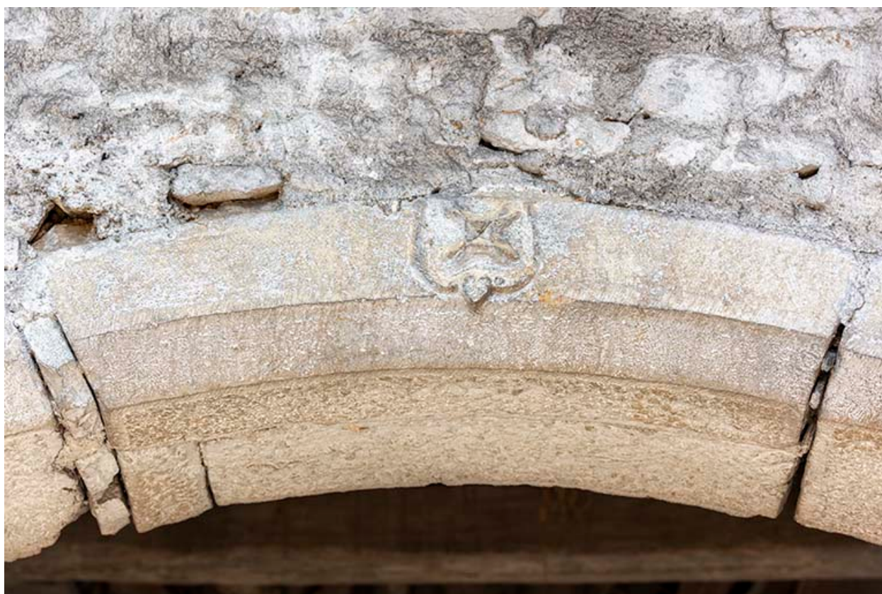
Grange, façade antérieure (partie orientale) : linteau orné
