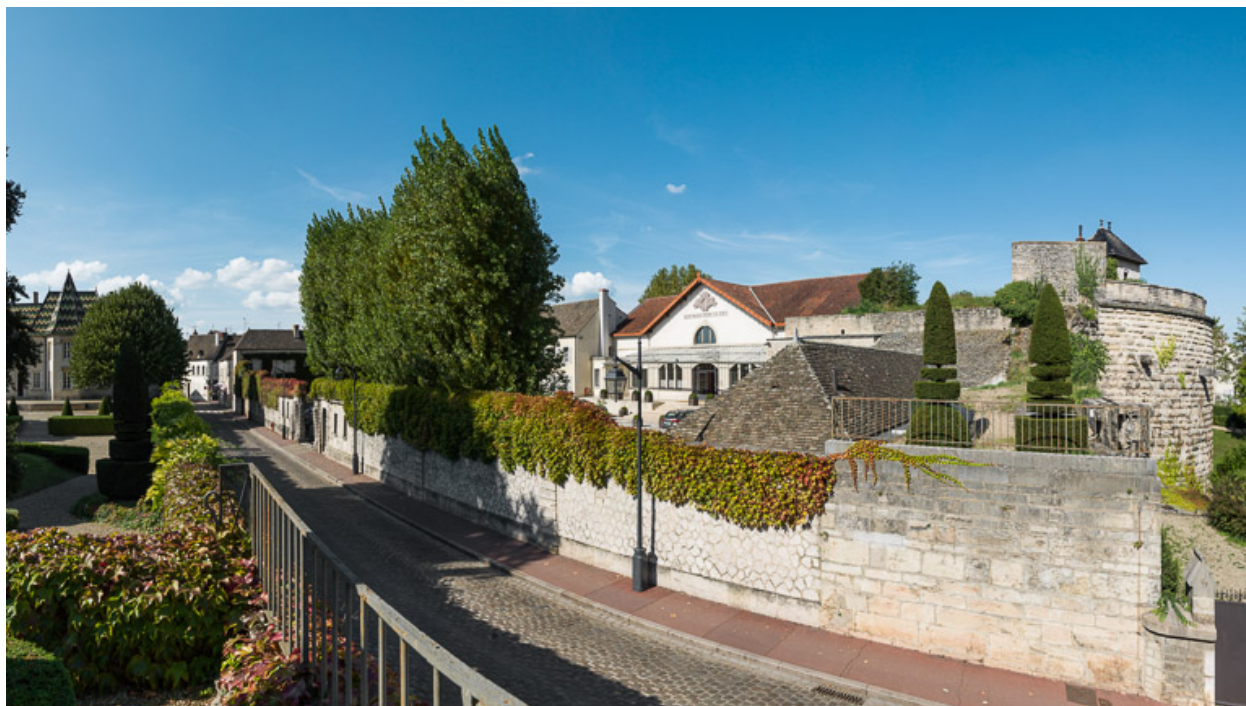
Rue du Château depuis le belvédère.
