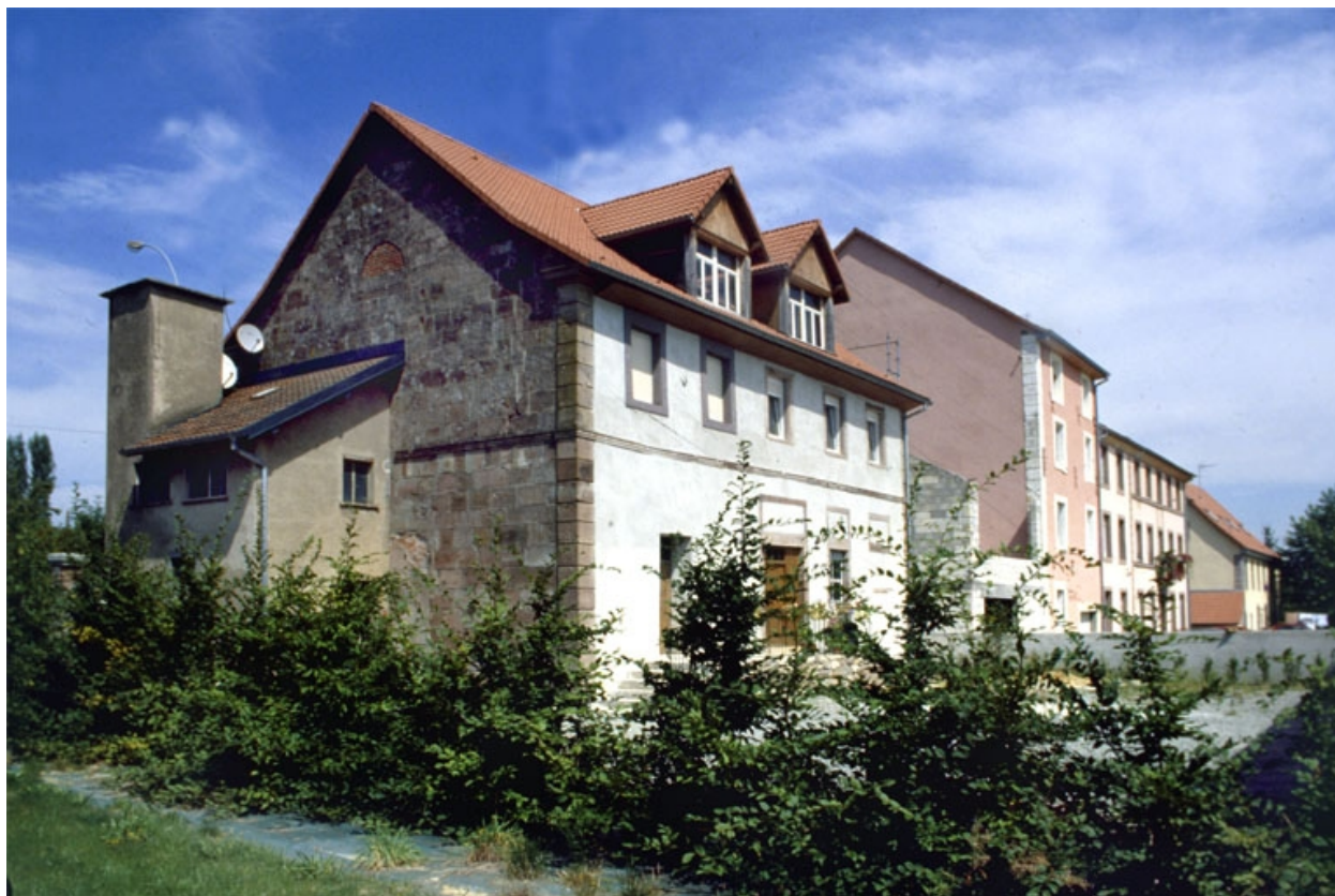
Façade postérieure des ateliers de fabrication.
