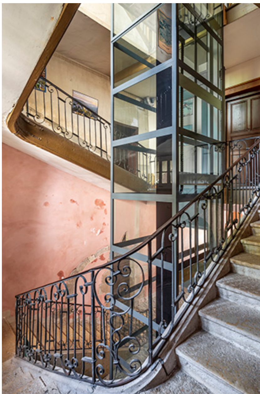
La cage d'escalier depuis le second repos.
