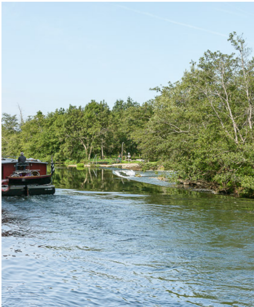
Vue du barrage à aiguilles.
