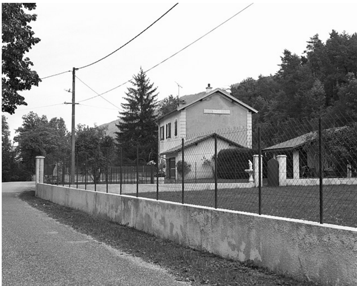
Vue d'ensemble, depuis la route au sud-ouest.
