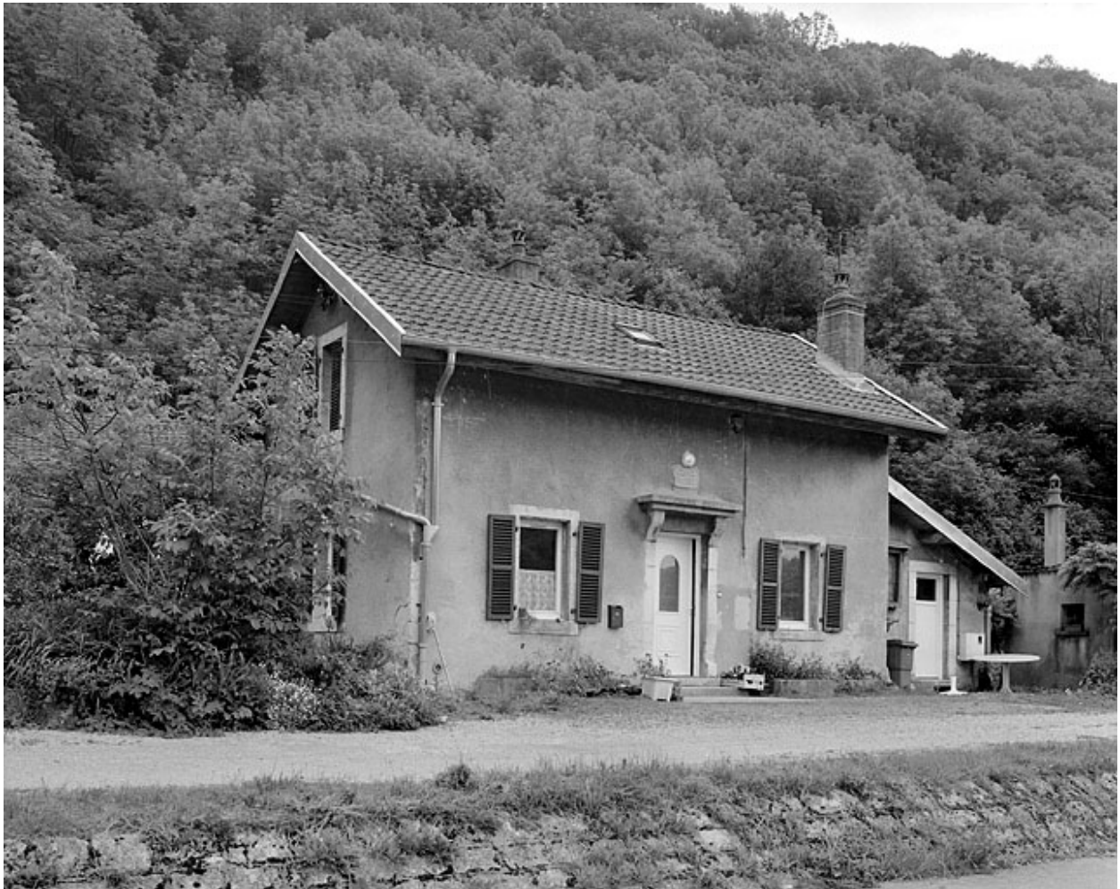
La maison d'éclusier, depuis l'écluse.
