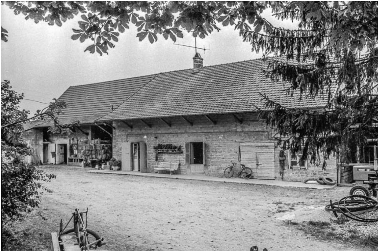
Ferme cadastrée 1969 AD 206-207 : bâtiment agricole.
