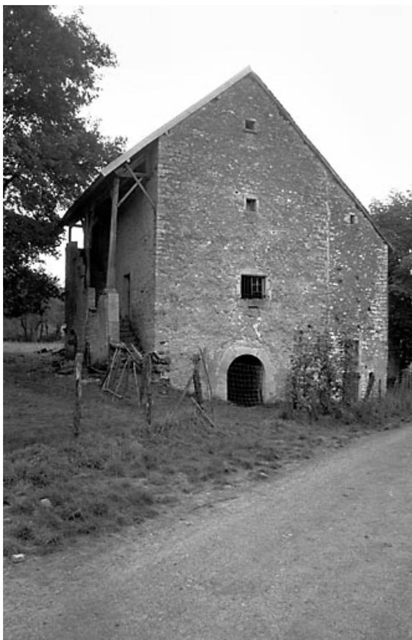
Façades antérieure et latérale droite.
