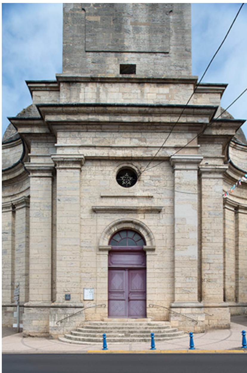
La façade principale et le portail d'entrée.
