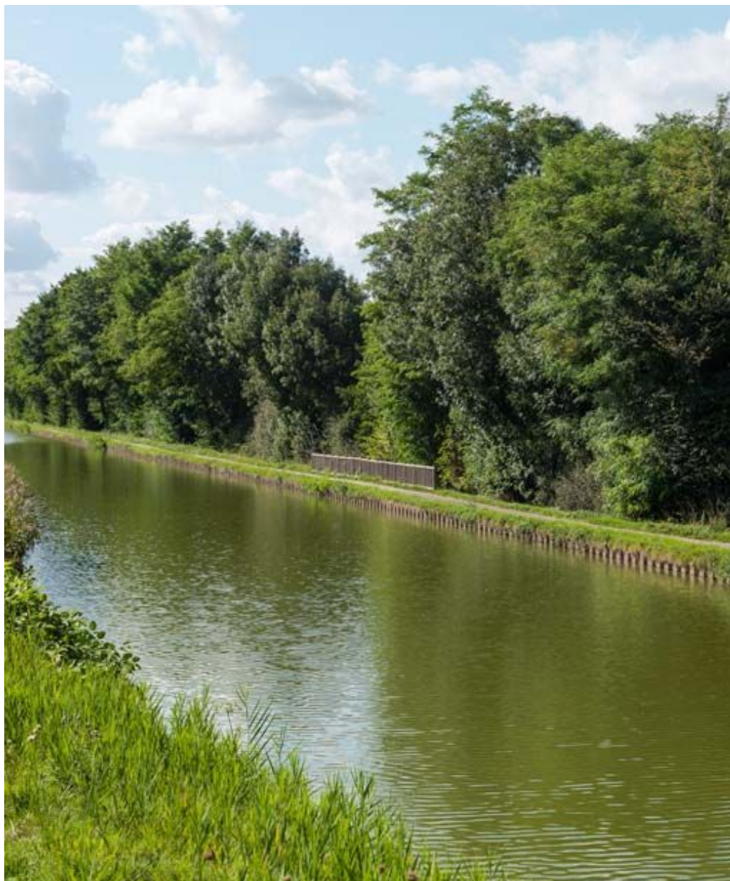
Vue de l'aqueduc-déversoir.
