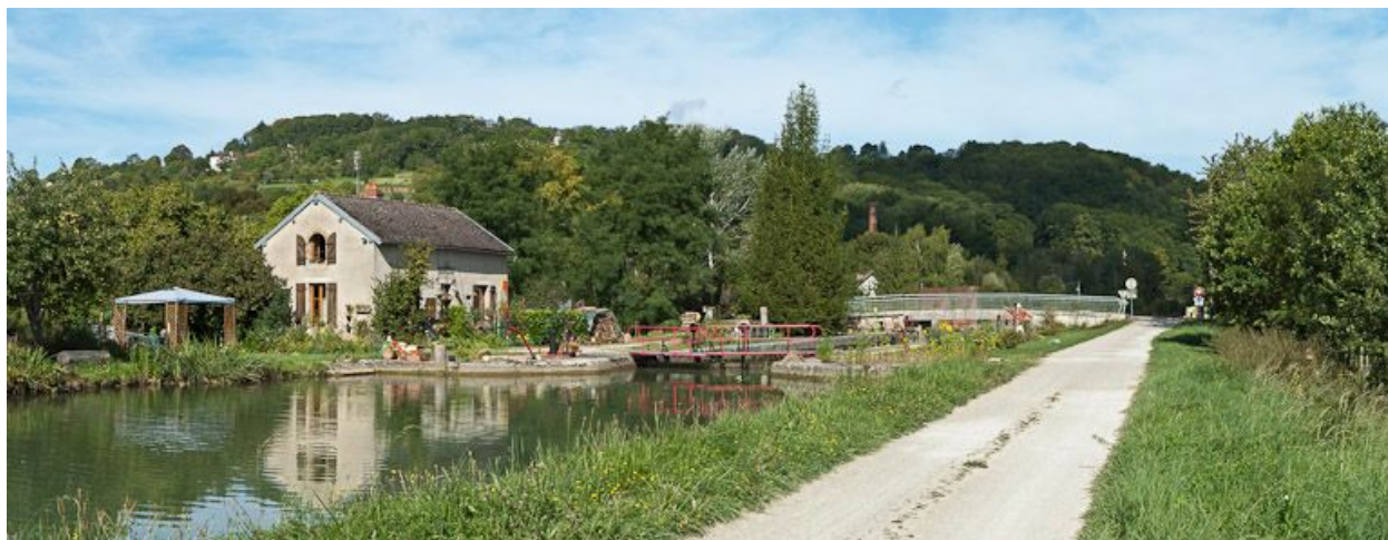
Vue du site d'écluse depuis l'amont.
