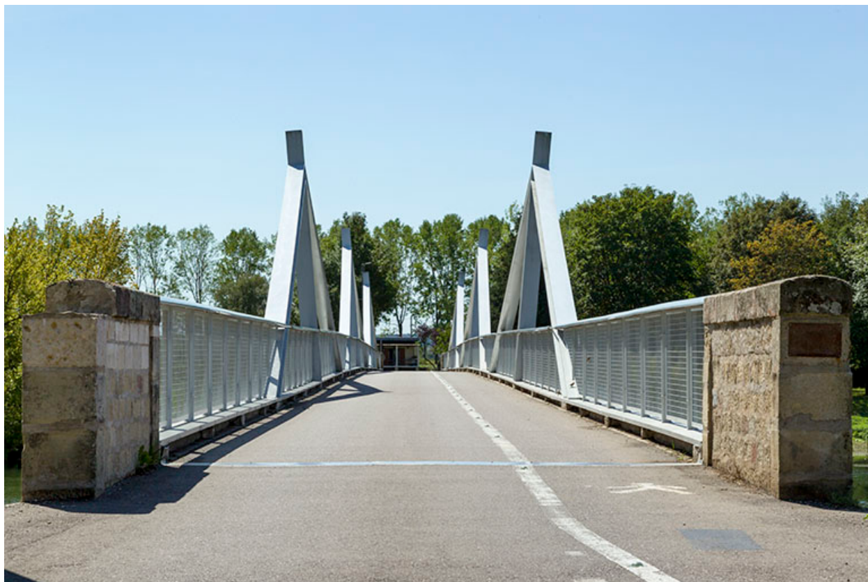
Pont de Rigny.
