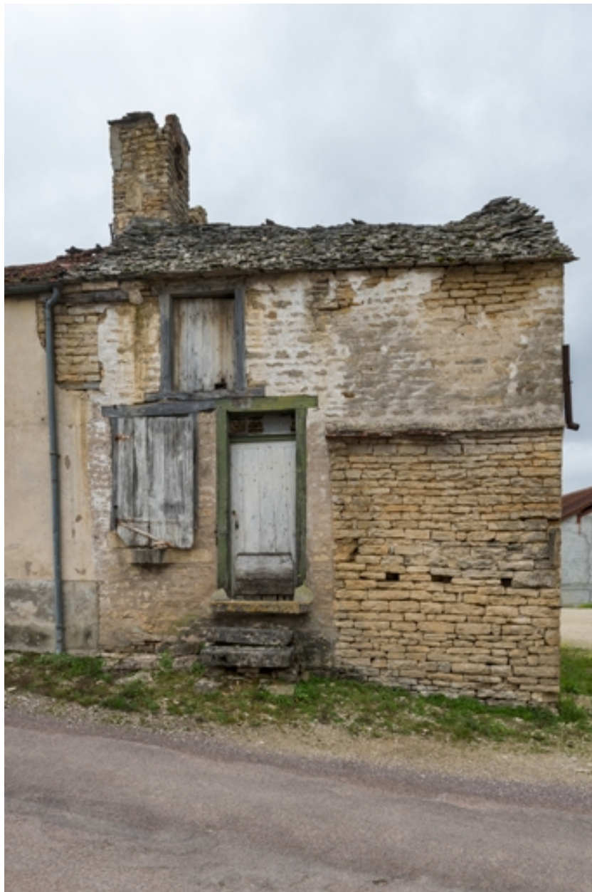
Vue de la façade ouest.
