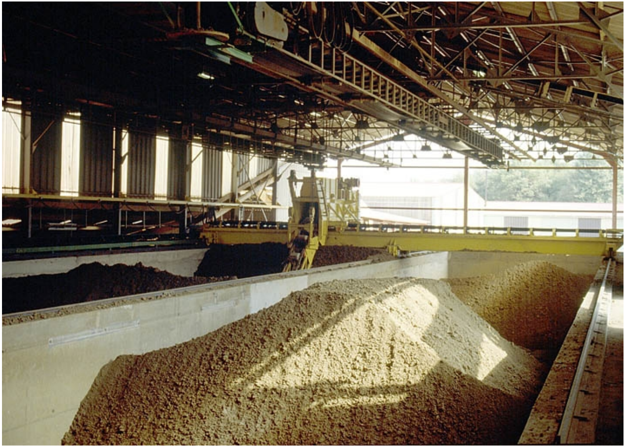
Intérieur du hangar à terre (I).
