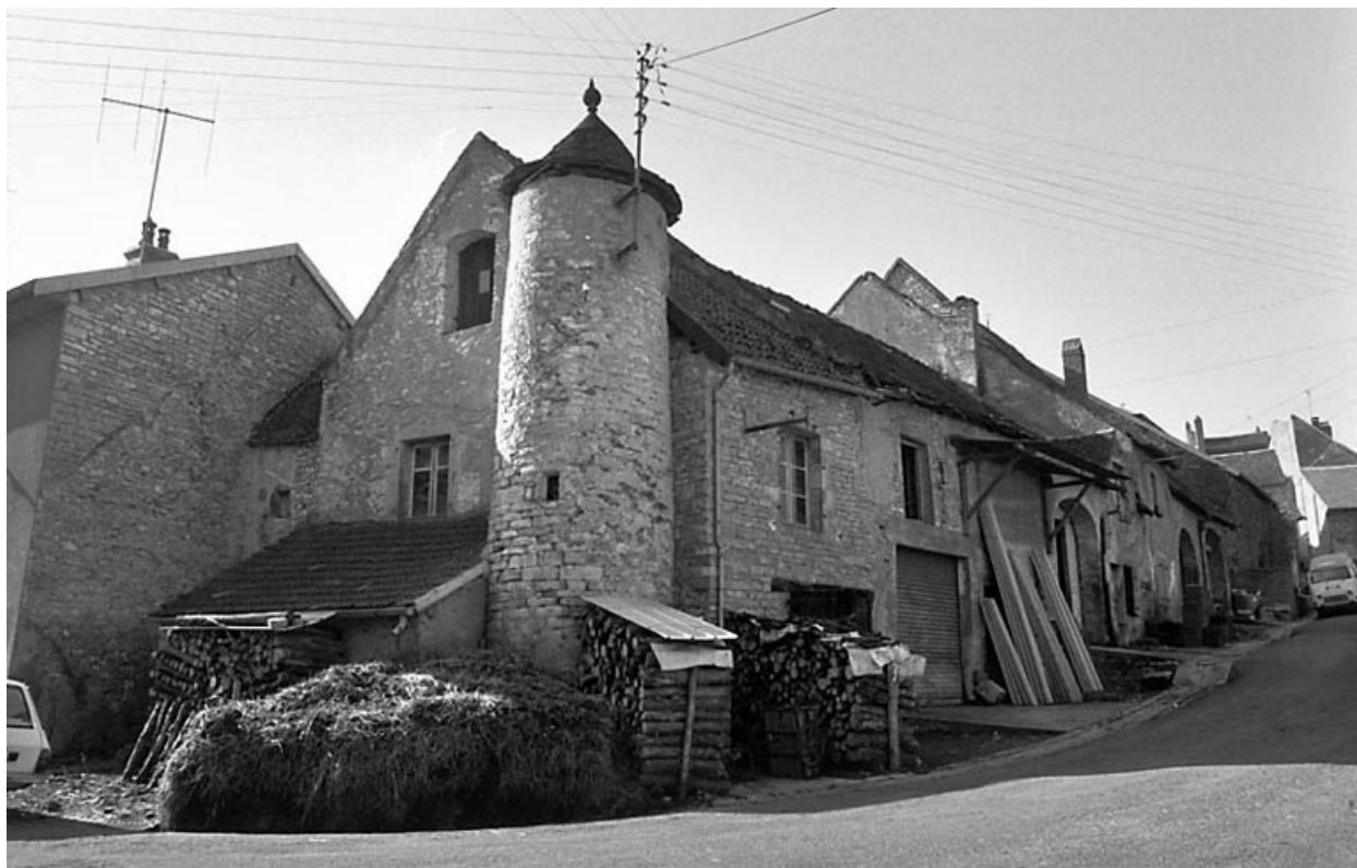
Maison située rue Gambetta.
