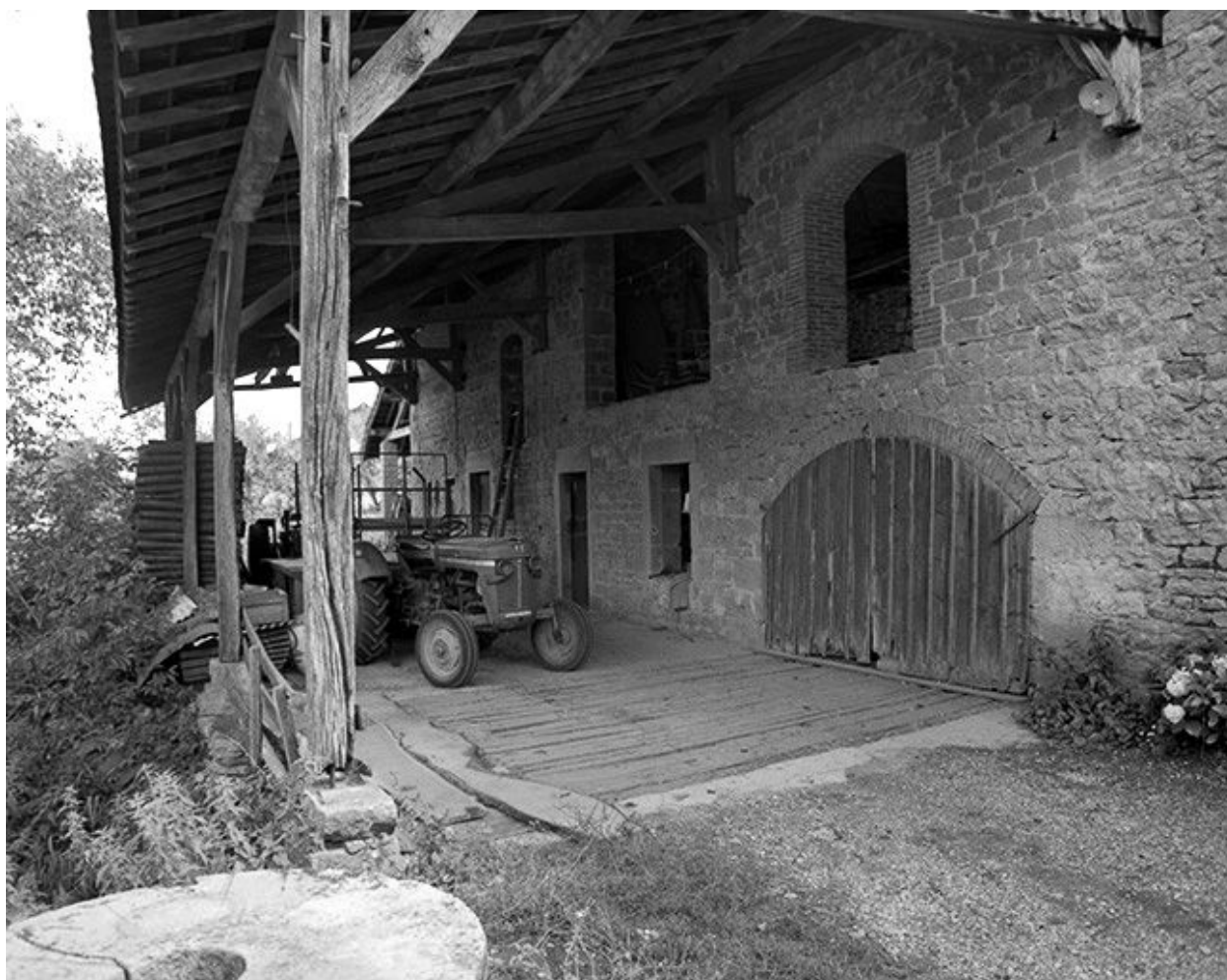
Façade antérieure, partie gauche.
