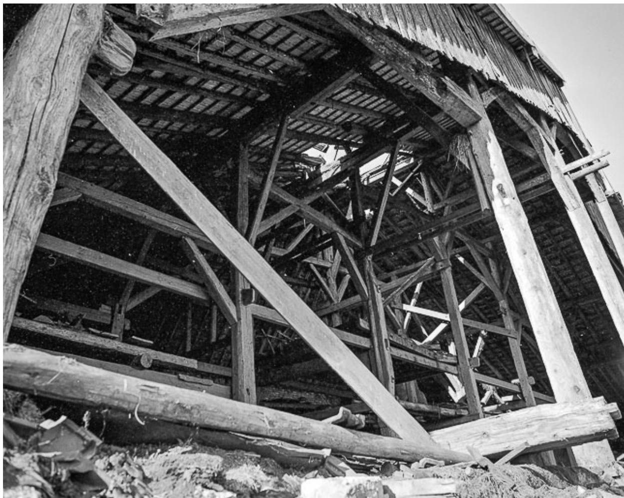
Ferme : facade postérieure (?) : détail.
