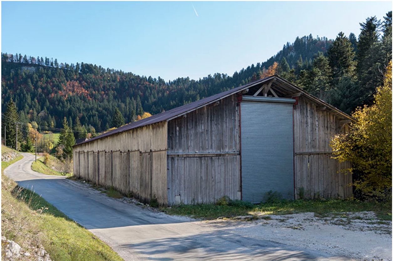
Hangar, au nord.
