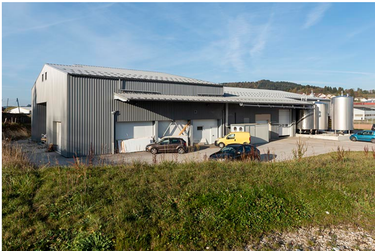
Façade latérale gauche, de trois quarts gauche.
