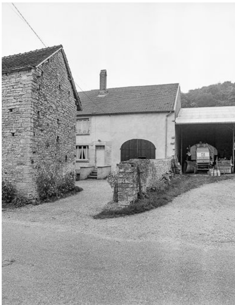
Façade sur cour.
