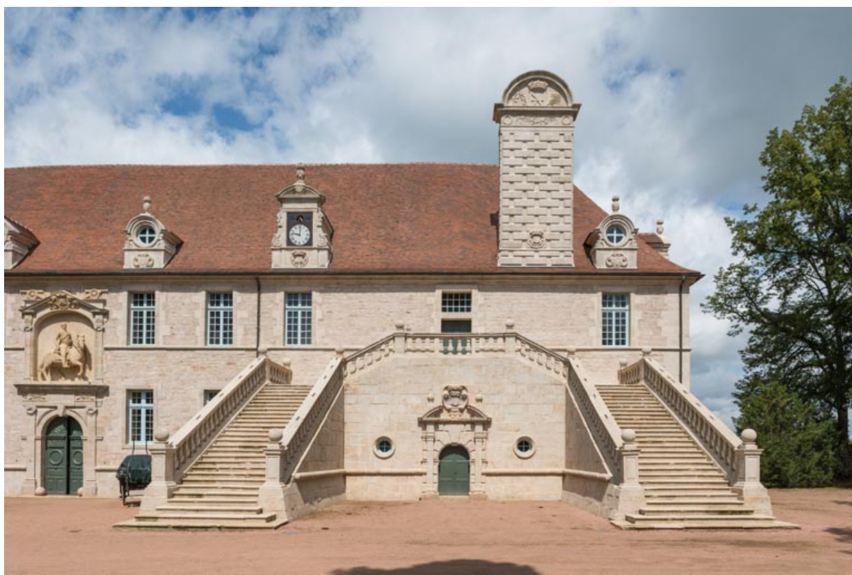
Façade sud-est, partie droite, grand-degré.
