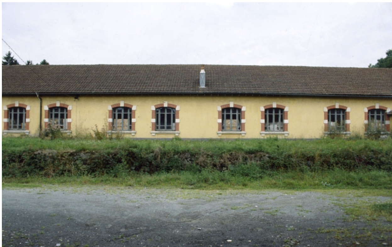
Façade sud de l'atelier de tissage.
