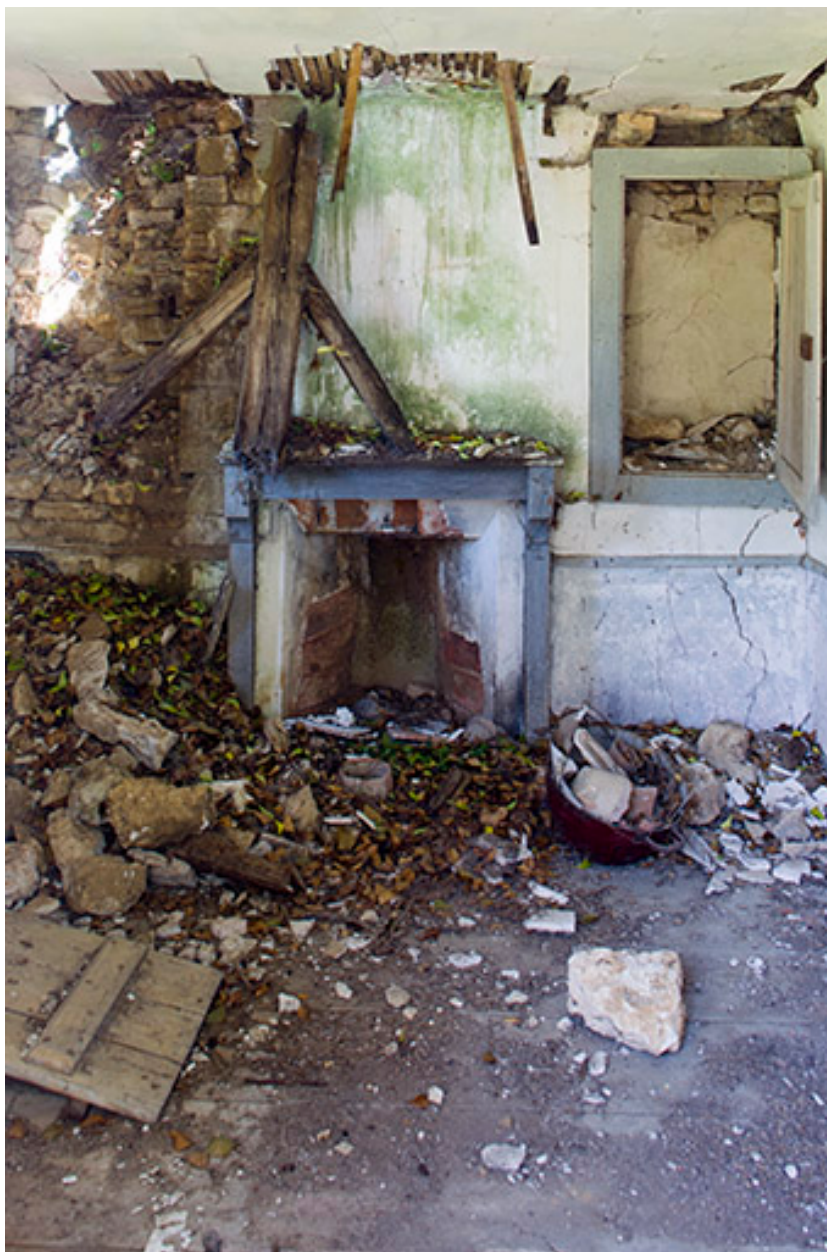
Intérieur du bâtiment : une pièce avec cheminée.
