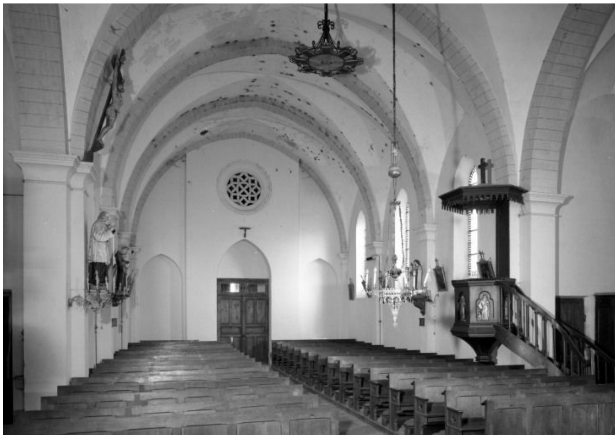
Vue intérieure prise du chœur
