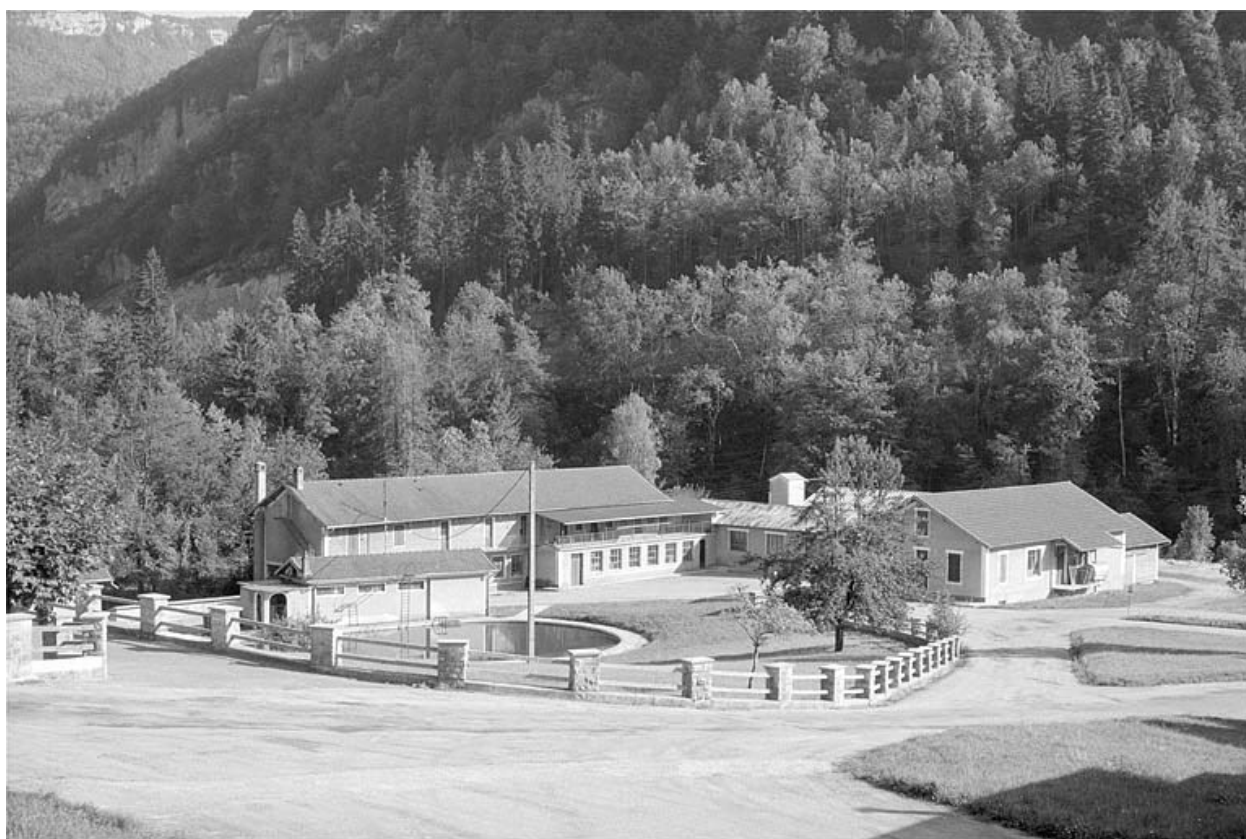
Ancienne usine, vue depuis le nord-ouest.
