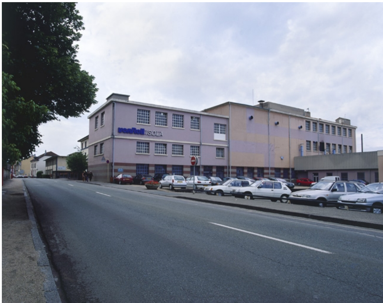
Atelier d'enduction verticale depuis le nord.
