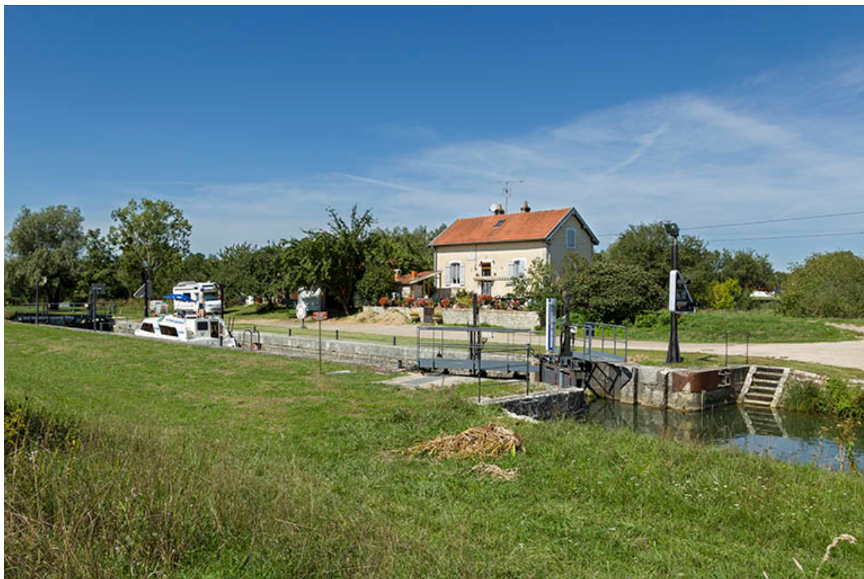
Maison du site d'écluse à Rigny (70).
