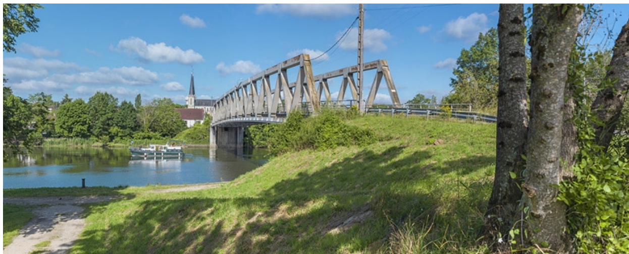
Vue d'ensemble, rive gauche.
