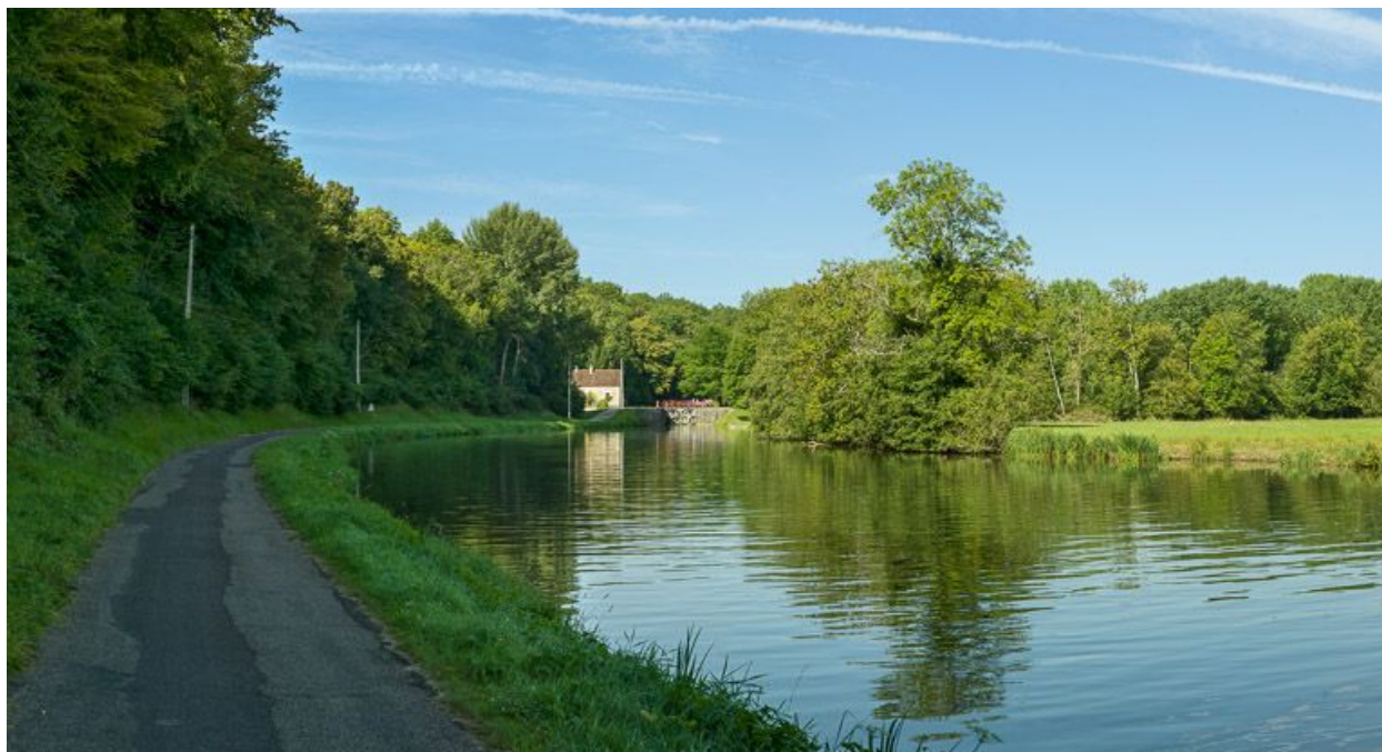
Vue d'ensemble du site pris d'aval.
