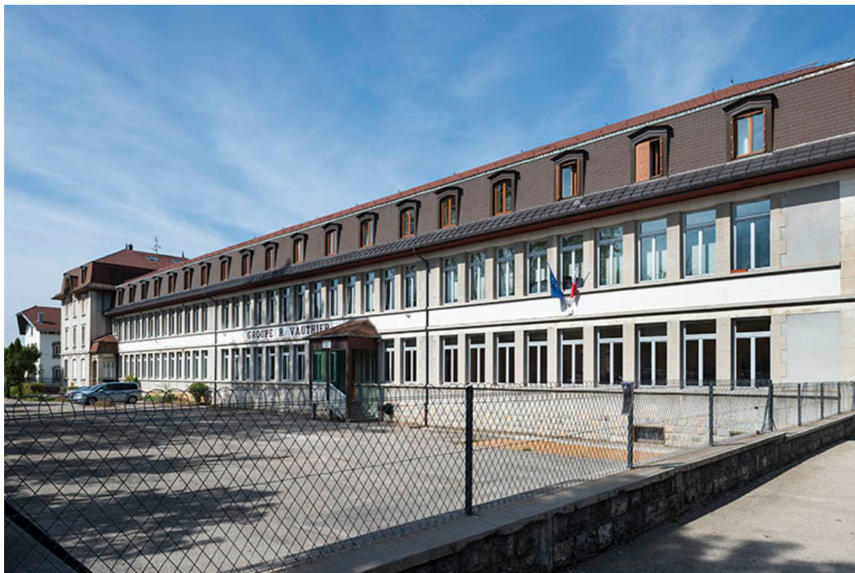
Façade sud vue de trois quarts droite.
