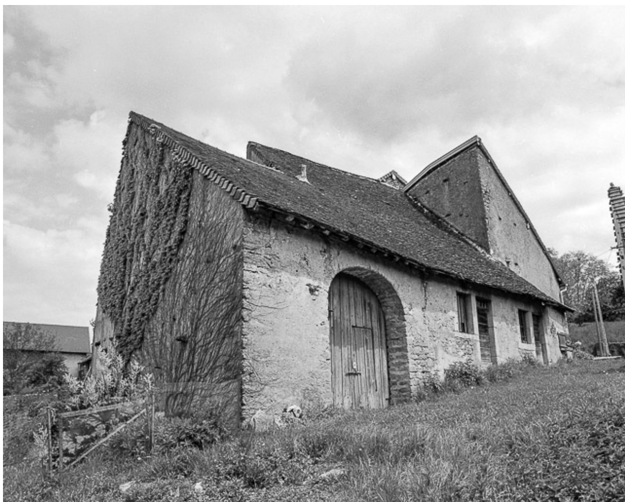
Ferme située rue Chateraine.
