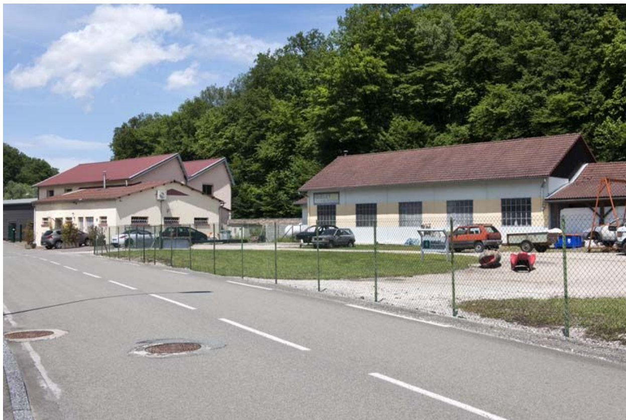
Vue rapprochée depuis le nord-ouest.
