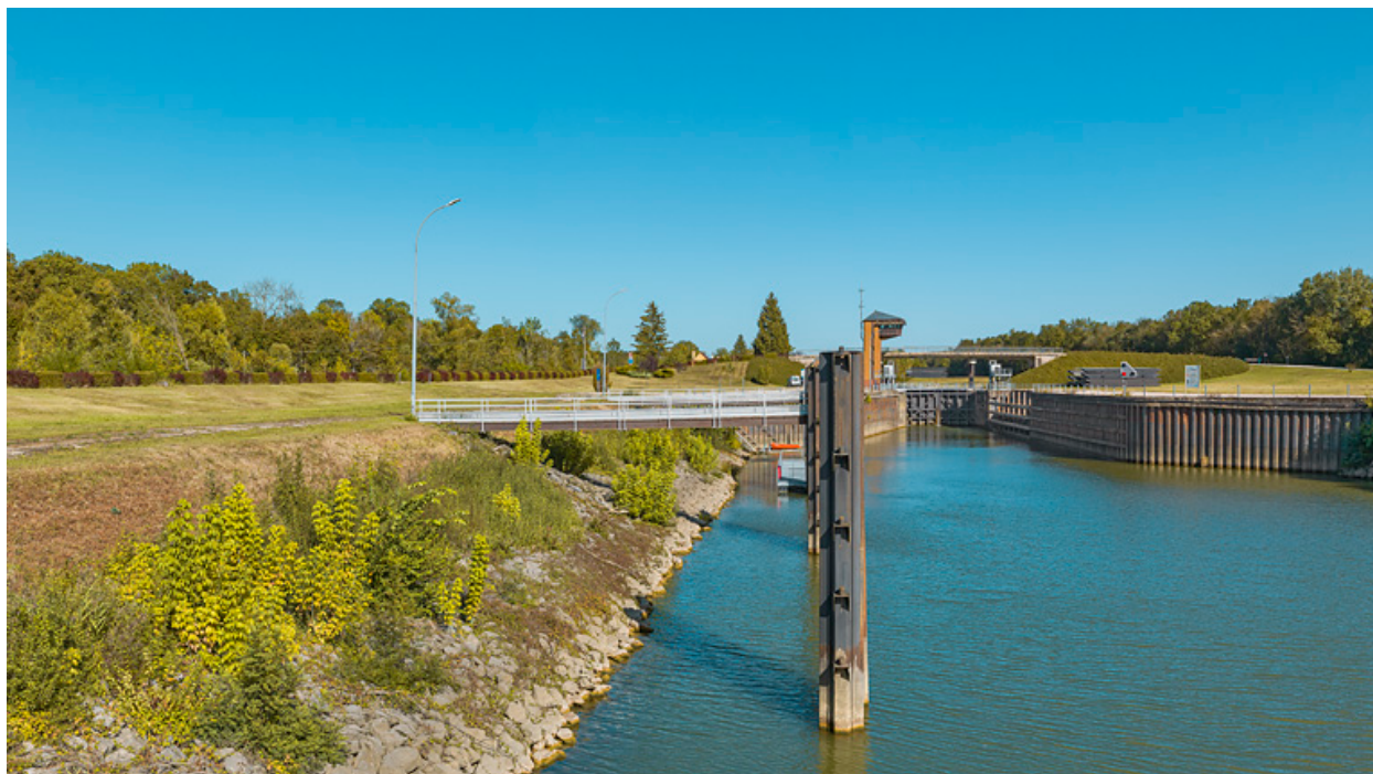
Le site vu d'aval.
