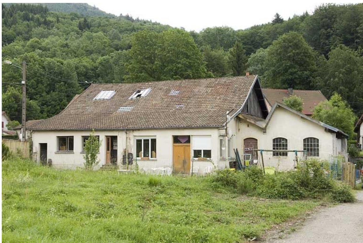
Atelier de réparation (entretien général).
