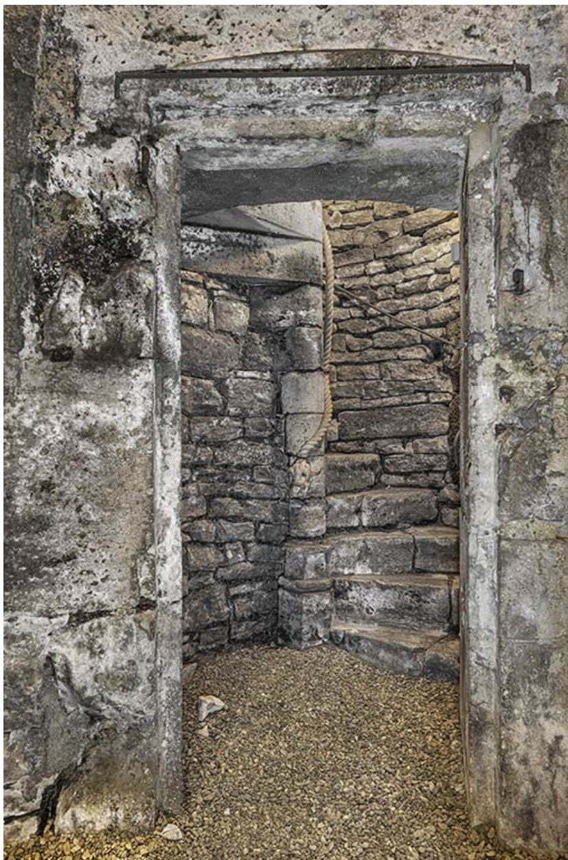
Première volée de l'escalier en vis.
