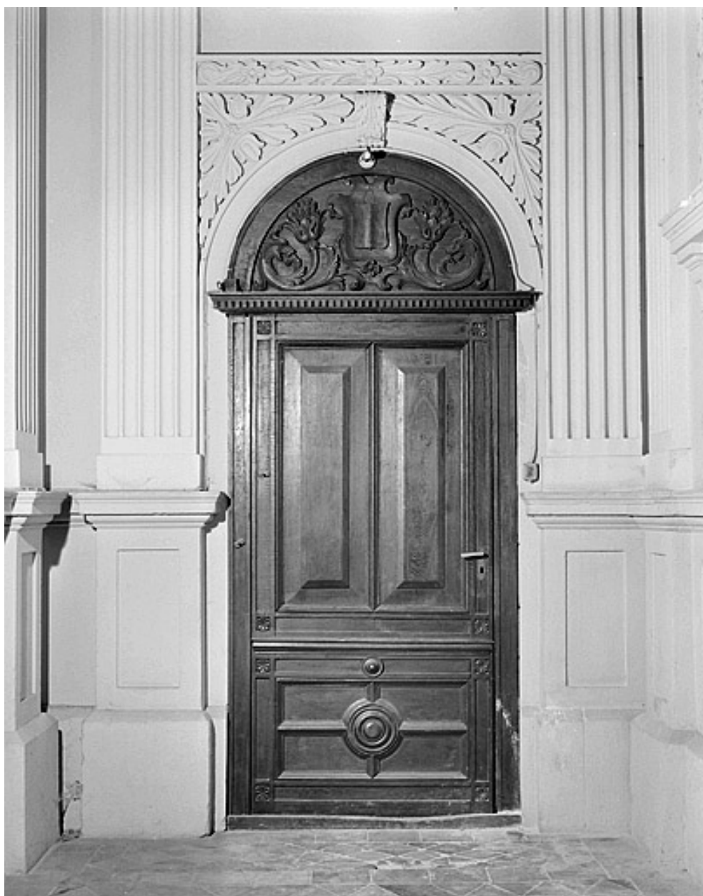
Vestibule, porte d'accès à la tour nord.
