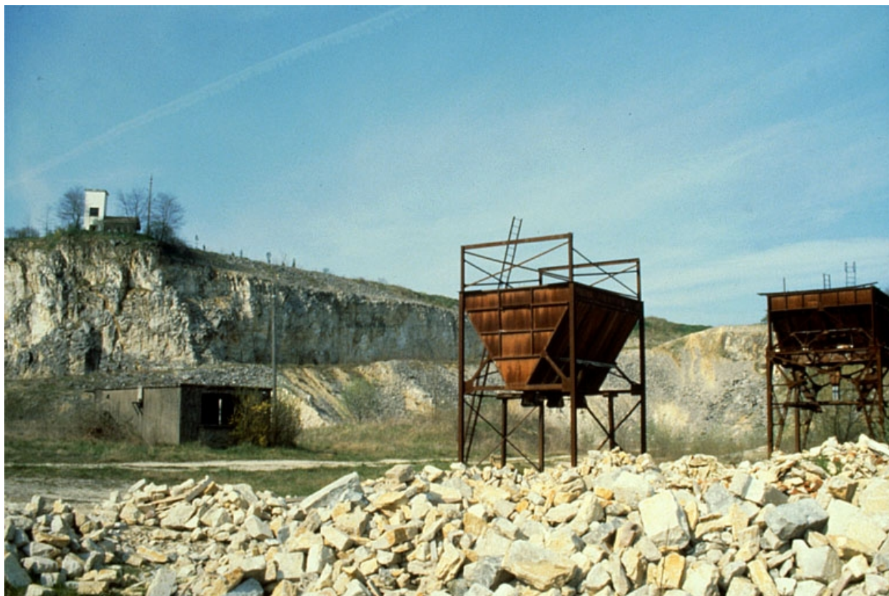
Transformateur, bureau et poste de chargement.
