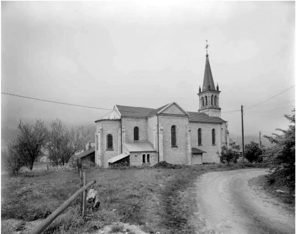
Façade latérale gauche et chevet de l'église.
