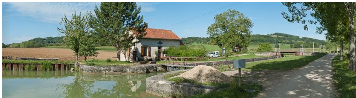
Vue d'ensemble du site d'écluse.
