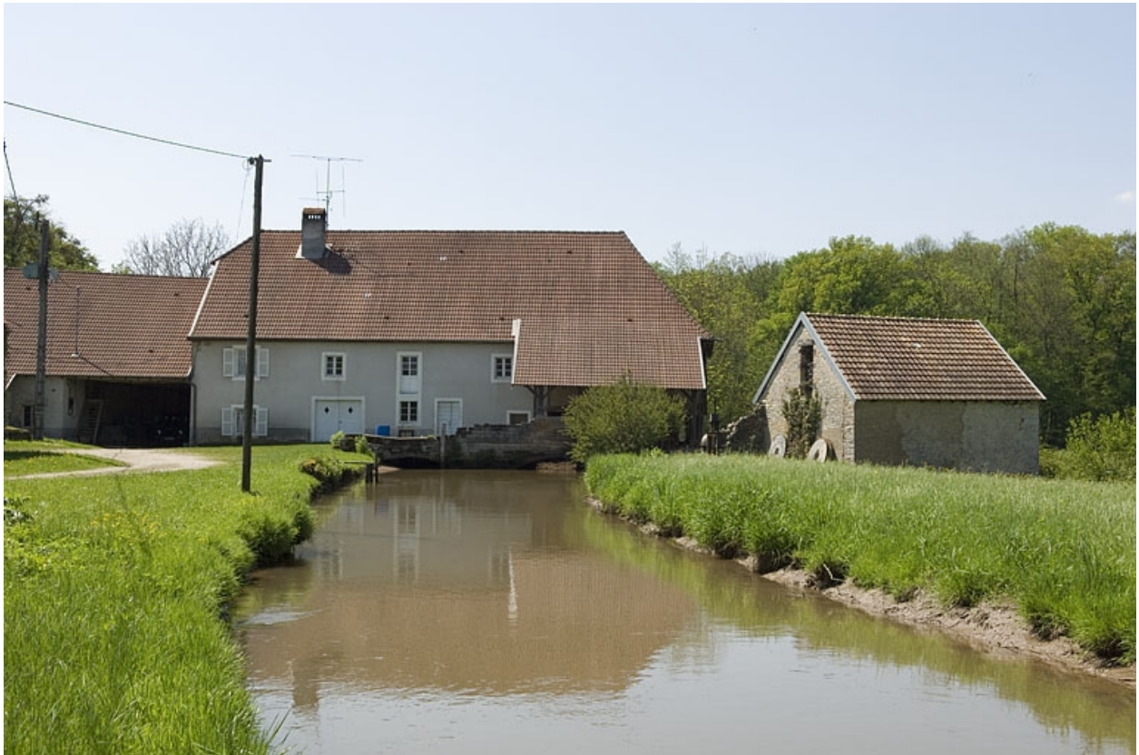
Vue d'ensemble depuis l'amont du bief.
