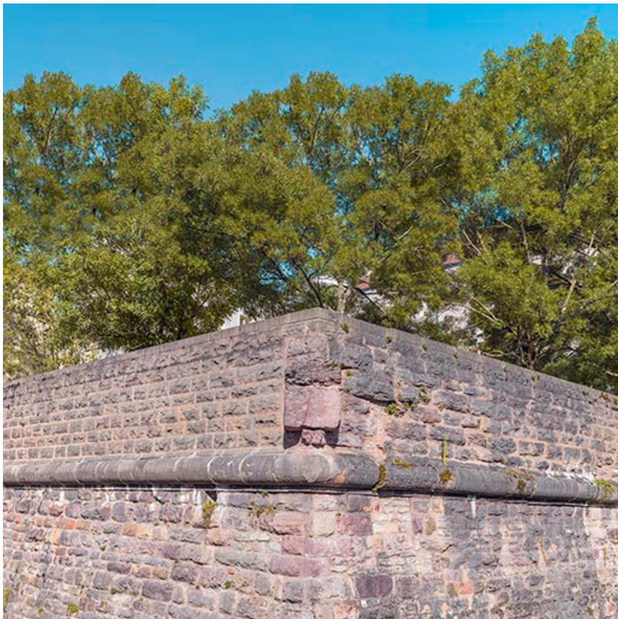
Détail de la maçonnerie.
